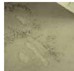
Silnější krusty je nutné odstranit přebroušením
