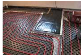
Podklad s fixovaným topným potrubím
