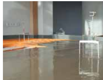
Strojní aplikace potěru na podlahové topení
