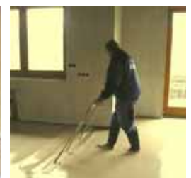
Zarovnání, odvzdušnění a homogenizace čerstvého potěru
